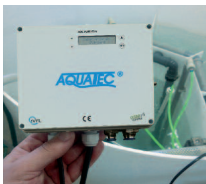
Detail mikroprocesorové řídicí jednotky AQC PLUS s automatizovaným řízením provozu ČOV
