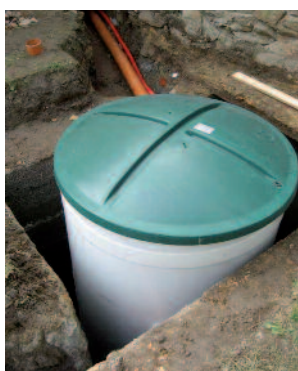
Příklad osazení domovní ČOV Aquatec AT6 do původního septiku
