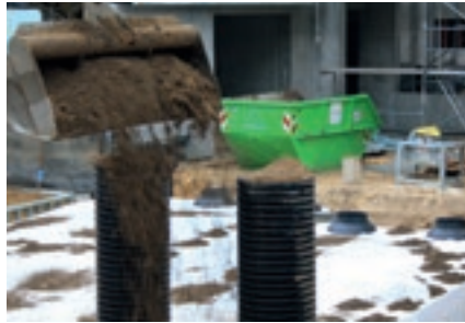
Funkce poklopu pro dobu výstavby při zásypu
