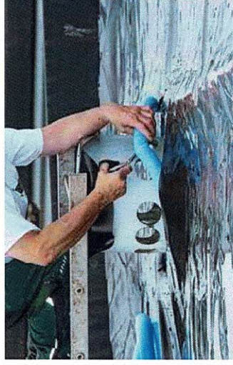
Installatie ring rondschuim / installation foam ring
