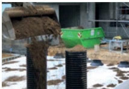
Funkce poklopu pro dobu výstavby při zásypu
