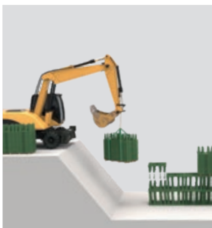
Montáž uvnitř stavební jámy
