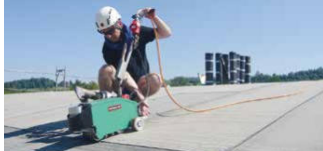
Bezplamenné svařování modifikovaného bitumenu - BITUMAT B2.
