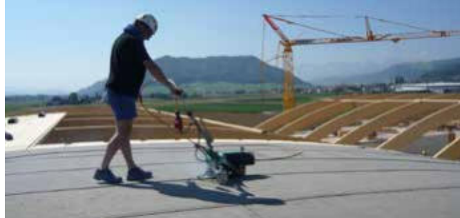
Bezplamenné svařování modifikovaného bitumenu.
