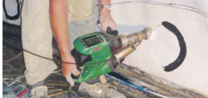
WELDPLAST S2 navařování záplaty v tunelu.
