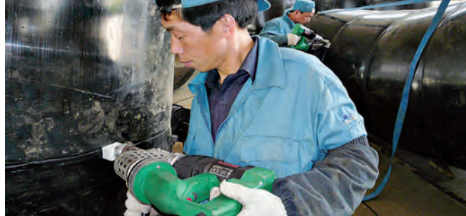
FUSION 2 během výroby nádrže v Číně.
