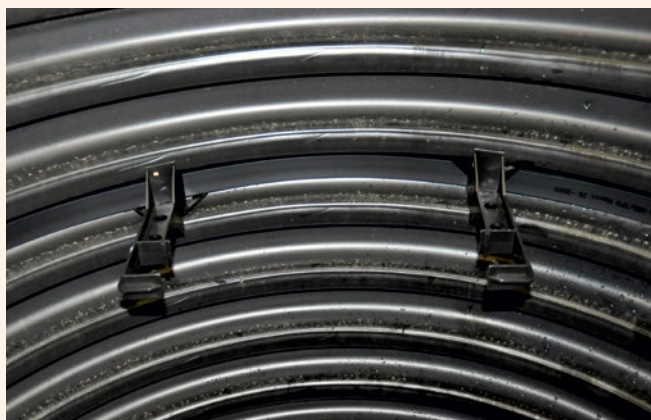
Předpříprava obruče žebříku v šachtové trubce
